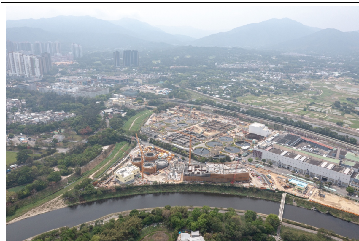
描述: 工地丙部分的1号航拍照片 (拍摄于2022年3月16日)
