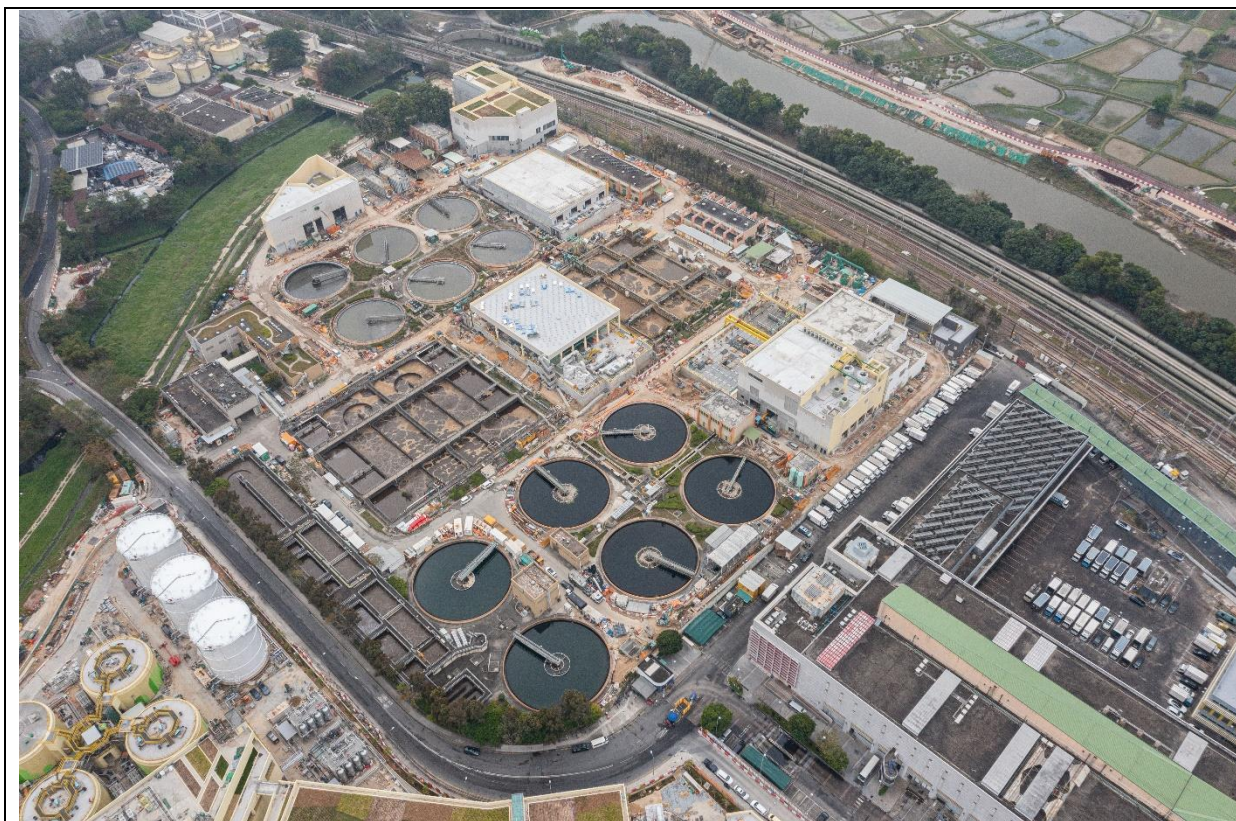
描述： 工地甲部分及乙部分的航拍照片 (拍攝於2025年2月17日)
