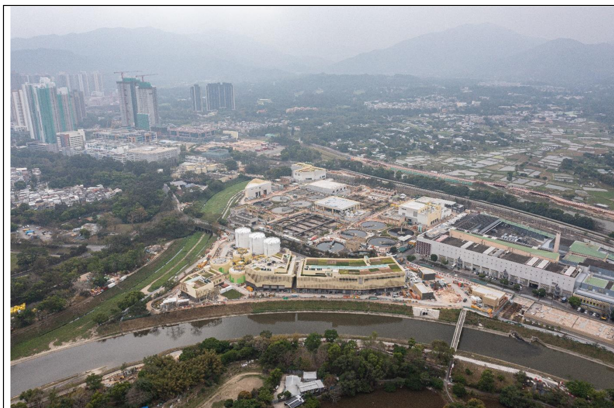
描述： 工地丙部分的航拍照片 (拍攝於2025年2月17日)
