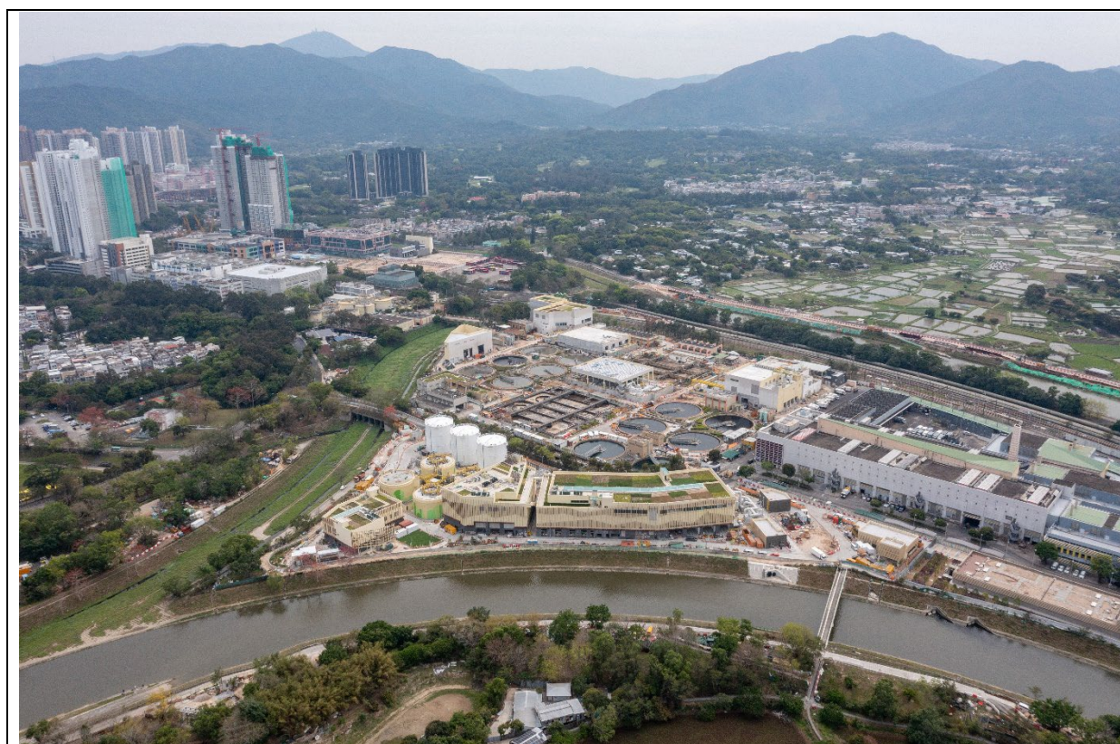
描述： 工地丙部分的航拍照片 (拍攝於2025年3月18日)
