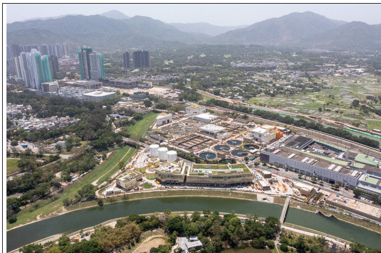
描述： 工地丙部分的航拍照片 (拍攝於2025年4月15日)
