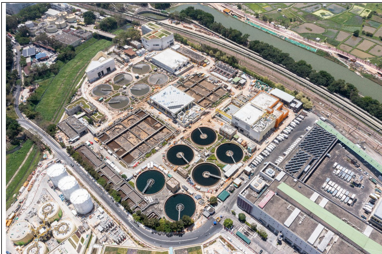
描述： 工地甲部分及乙部分的航拍照片 (拍攝於2025年4月15日)
