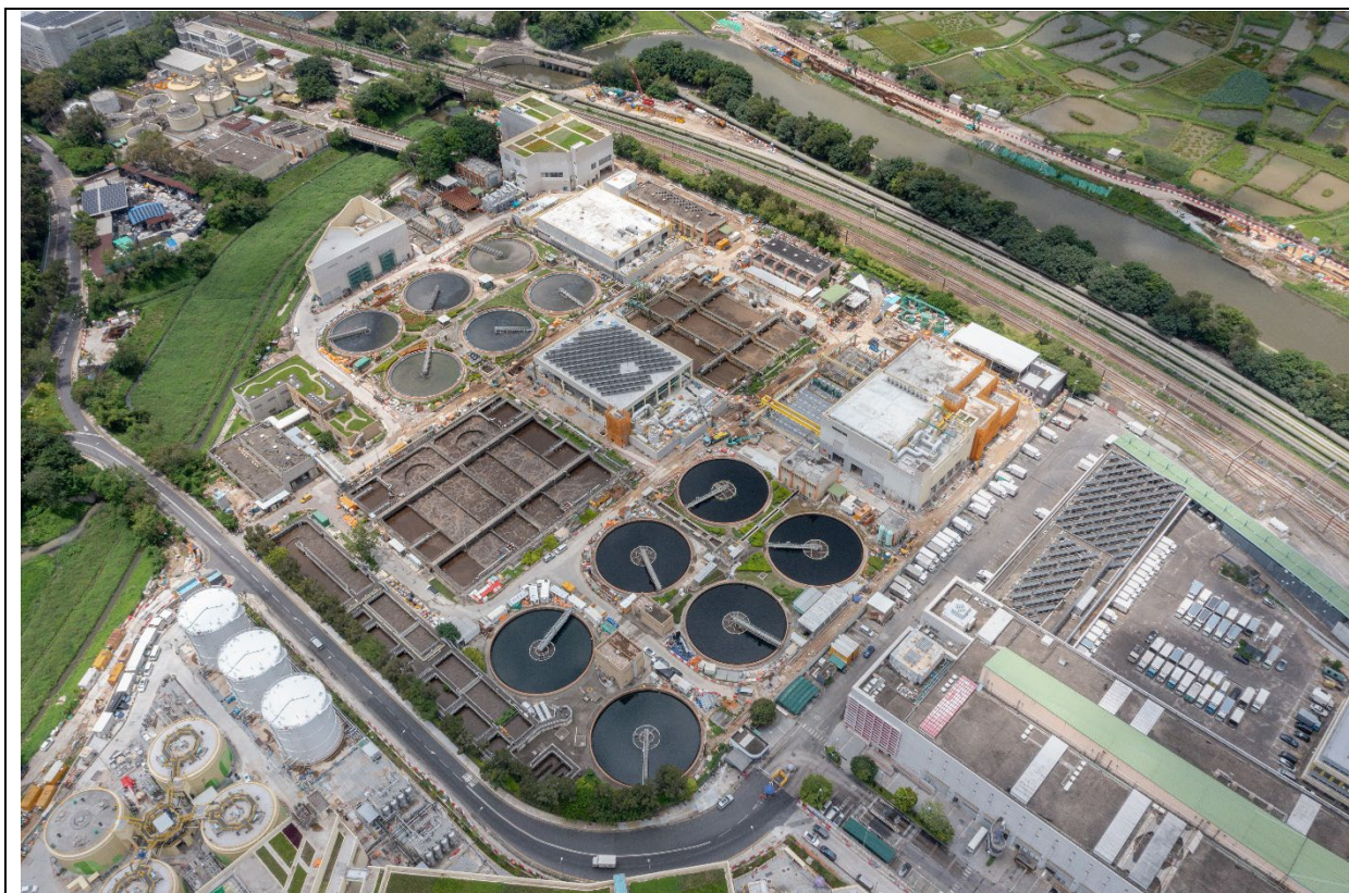
描述： 工地甲部分及乙部分的航拍照片 (拍攝於2025年6月24日)
