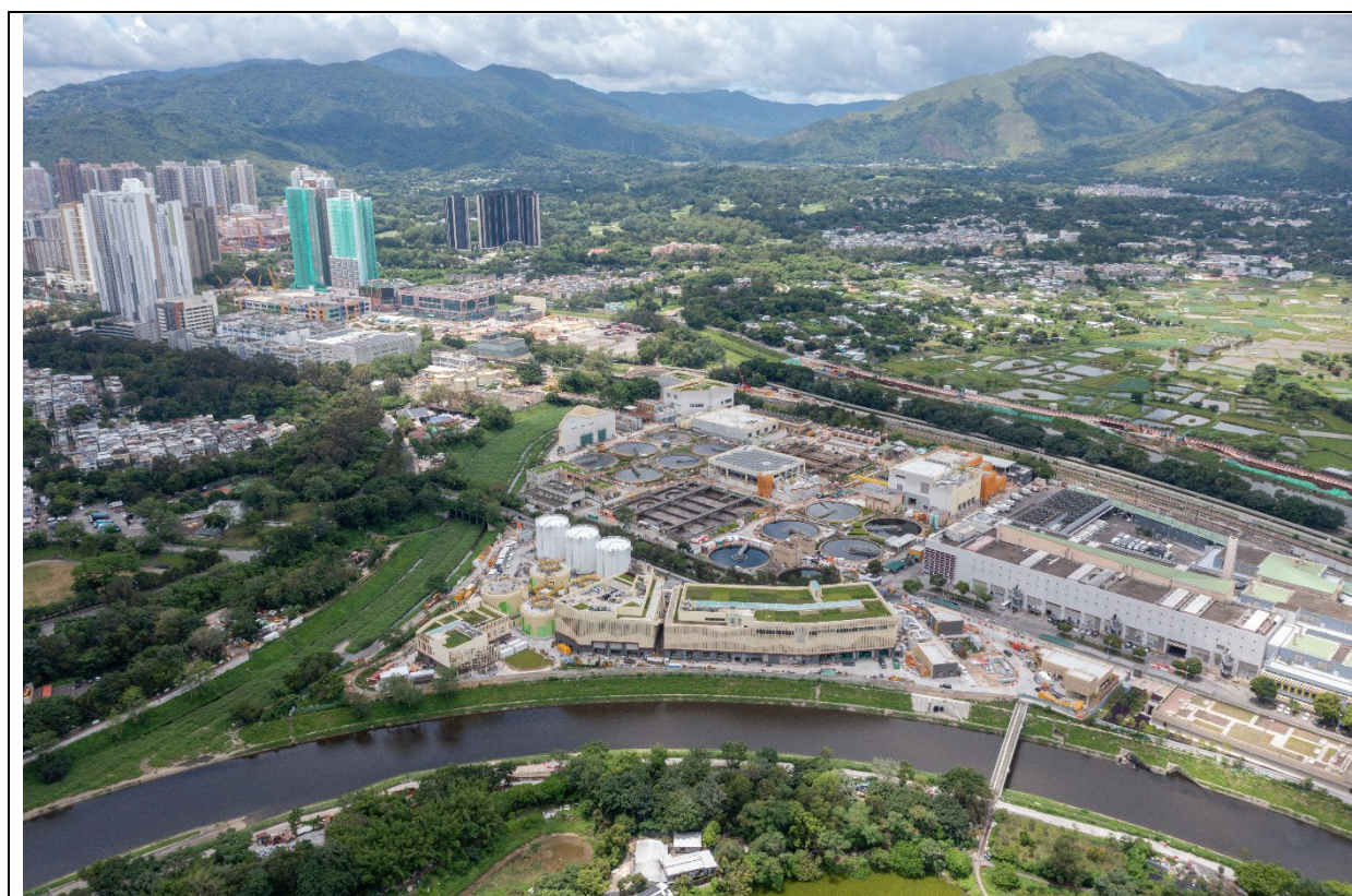
描述： 工地丙部分的航拍照片 (拍攝於2025年6月24日)
