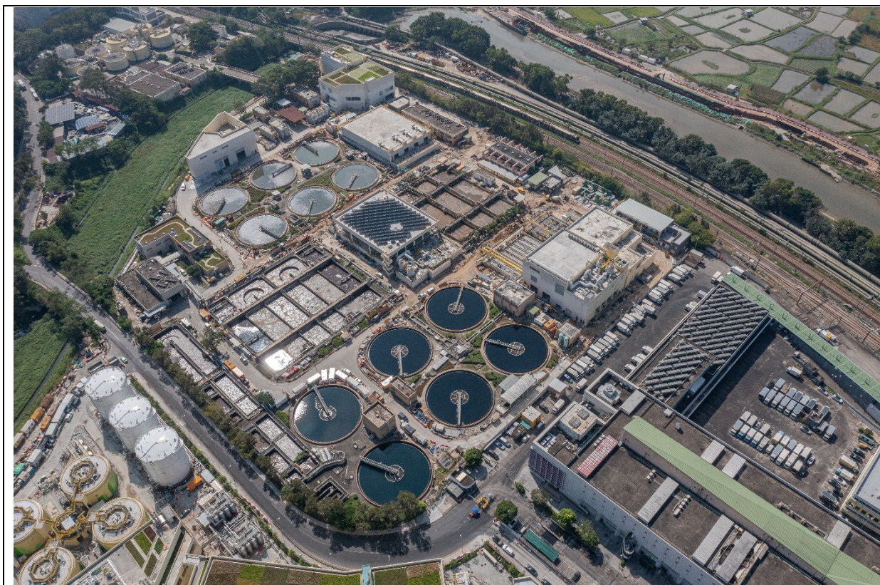
描述： 工地甲部分及乙部分的航拍照片 (拍攝於2025年11月13日)
