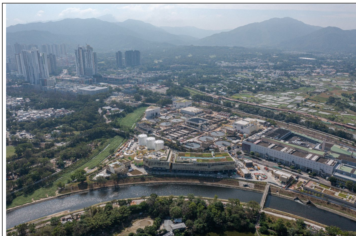
描述： 工地丙部分的航拍照片 (拍攝於2025年11月13日)
