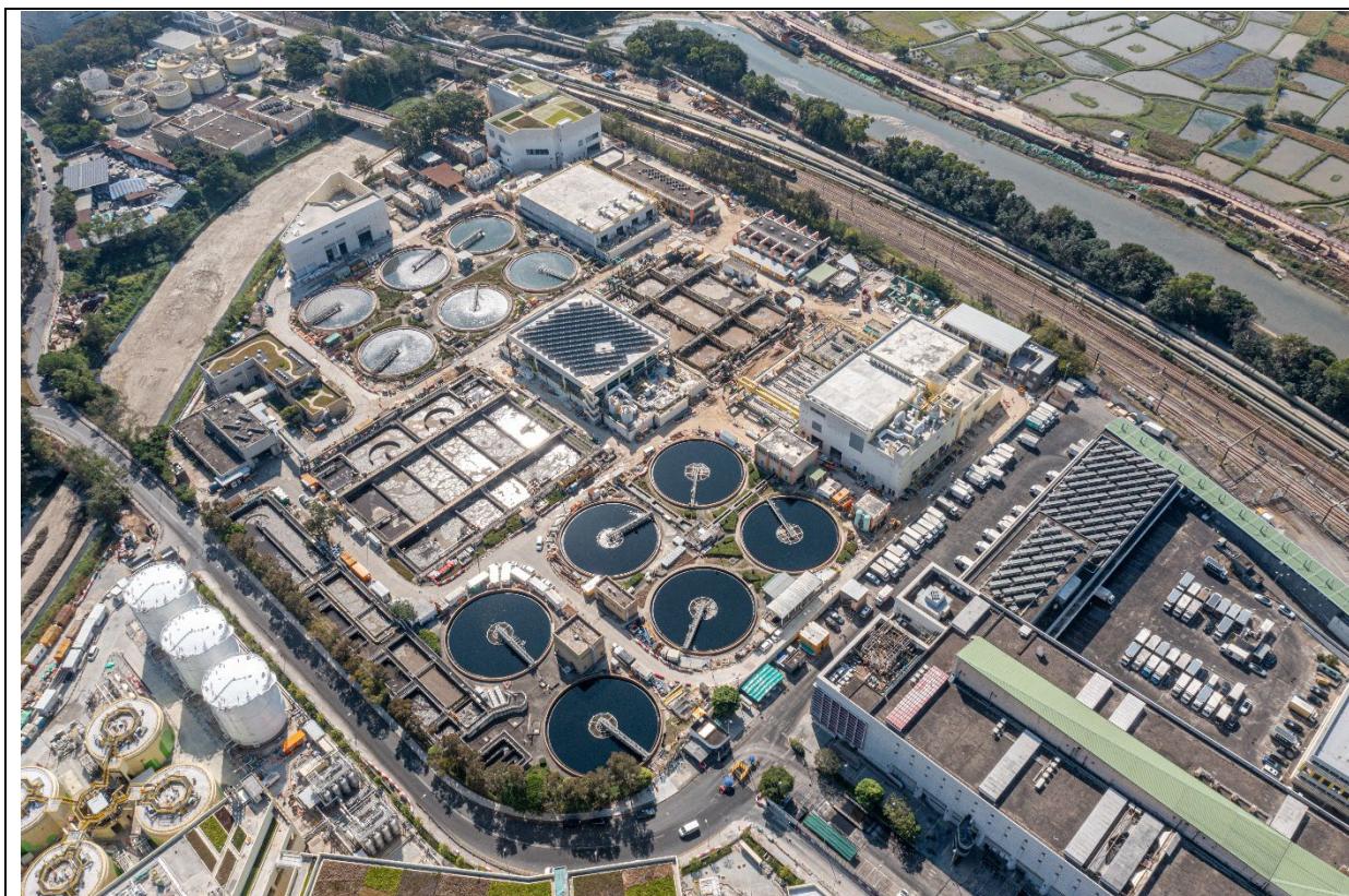
描述： 工地甲部分及乙部分的航拍照片 (拍攝於2025年12月14日)
