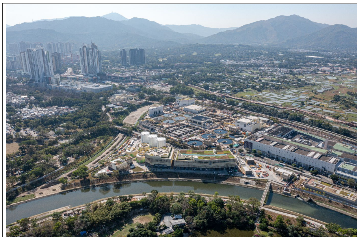
描述： 工地丙部分的航拍照片 (拍攝於2025年12月14日)
