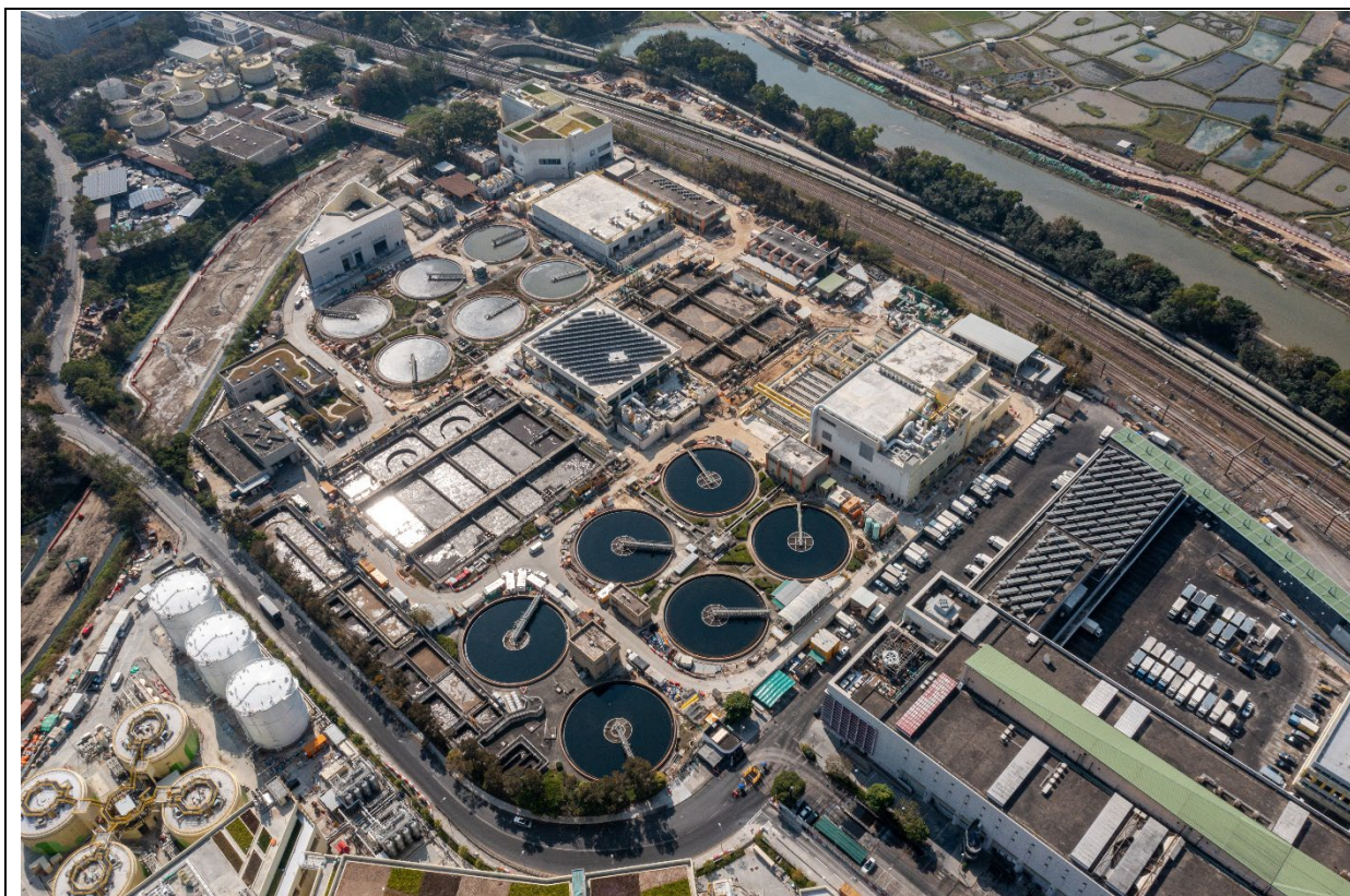
描述： 工地甲部分及乙部分的航拍照片 (拍摄于2026年1月18日)
