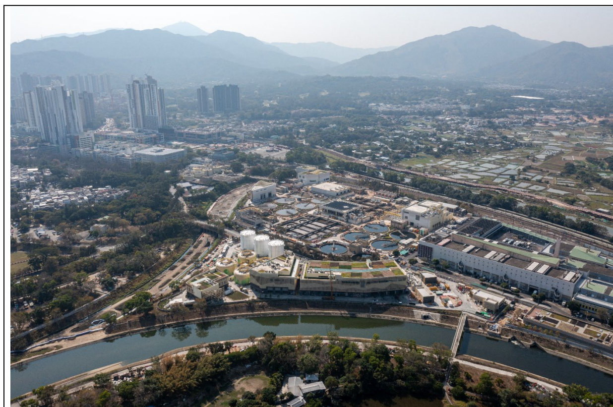
描述： 工地丙部分的航拍照片 (拍摄于2026年1月18日)
