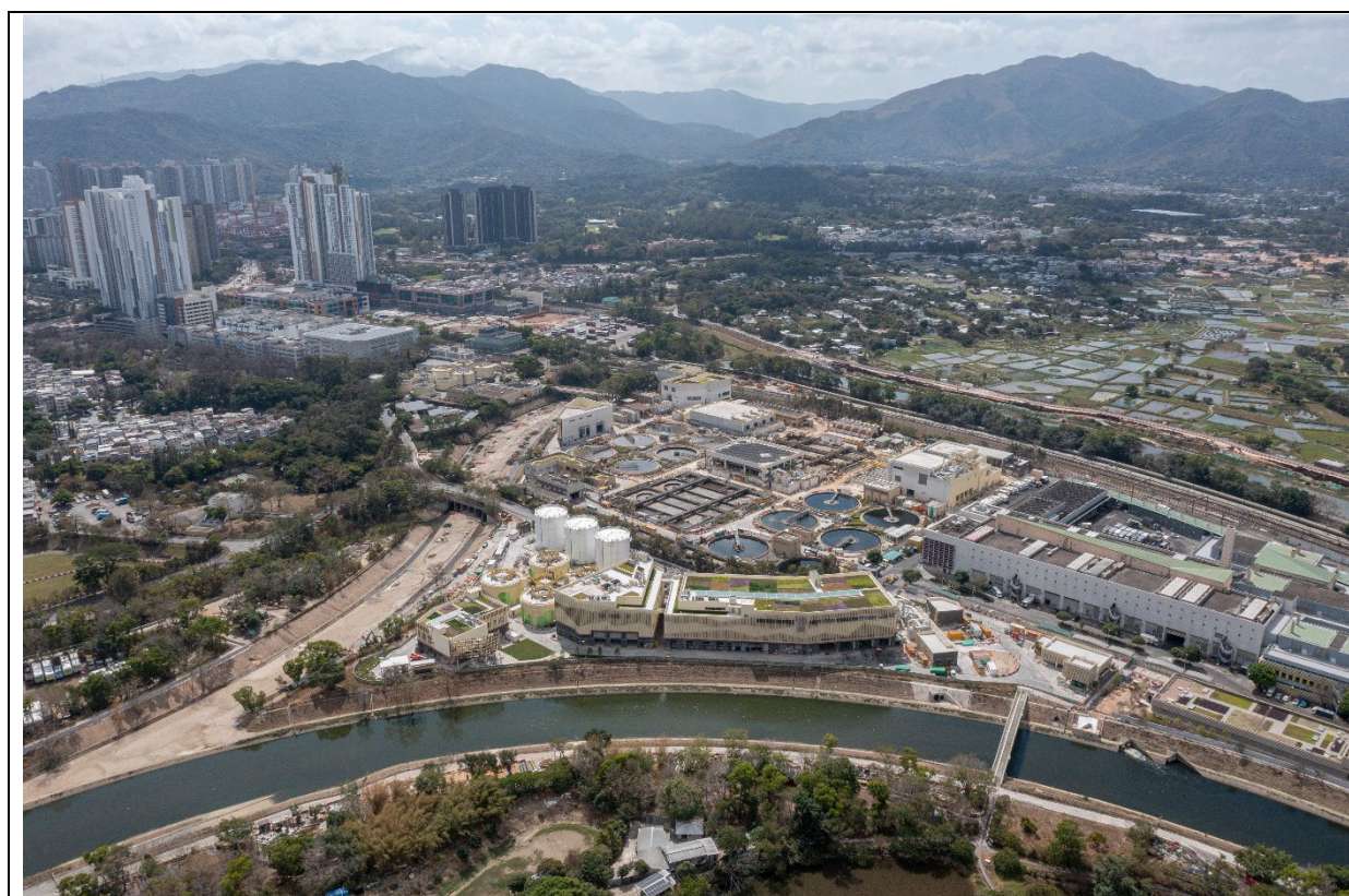
描述： 工地丙部分的航拍照片 (拍攝於2026年2月15日)
